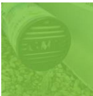
piscinas. Durante un importante vertido de aceite, el componente reacciona y forma instantáneamente un tapón hermético hasta 1 bar de presión, impidiendo así que cualquier fluido se vierta en el medio ambiente. Un prefiltro interno adaptable está provisto para limitar el ensuciamiento del filtro interno. Los filtros pueden montarse en serie en caso de caudales más importantes.
