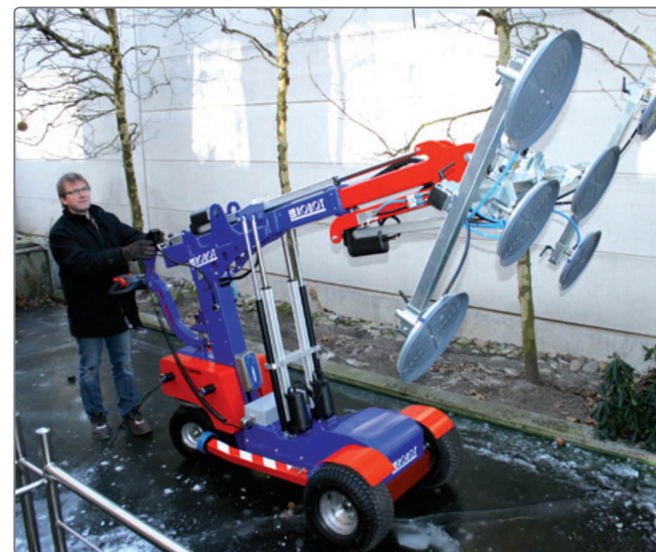
Un estanque congelado es la única superficie posible sobre la que situarse para realizar unas reparaciones en altura de vidrios.
