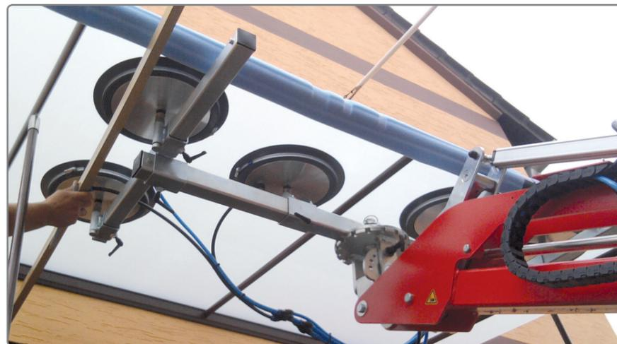
Incluyendo módulo de acristalamientos de techo para la flexibilidad necesaria durante la instalación.
