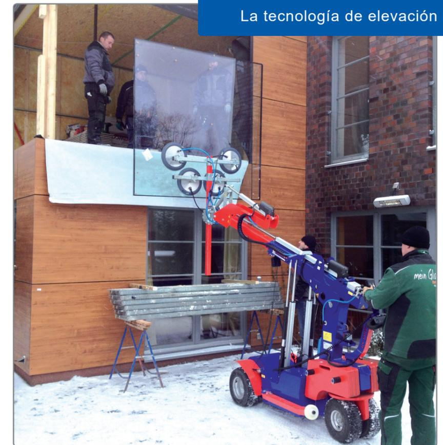
Control sincrónico de calidad y sistema de accionamiento garantizar suave y fluido movimientos. Fig. Muestra Robot KS 400 Offroad.
