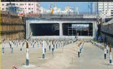
Anclajes de subpresión
