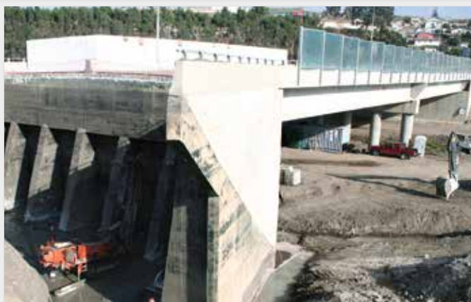
Recalce de un estribo de puente con 40 micropilotes TITAN 103/78 en una región fuertemente sísmica en Chile, en el año 2009.
