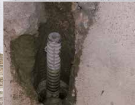
Micropilotes TITAN en base de excavación
