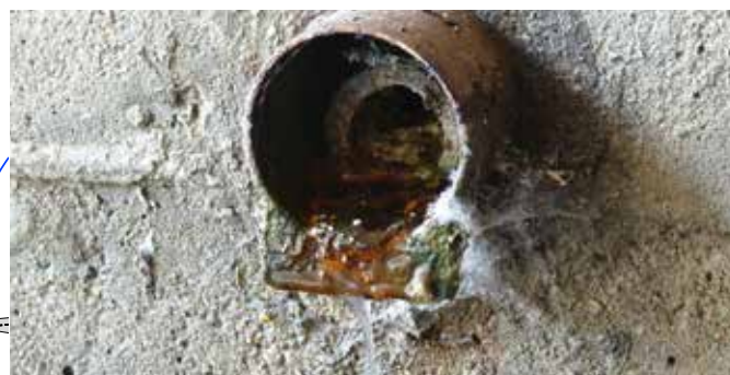
6 años tras la instalación - El drenaje del macizo es visible
