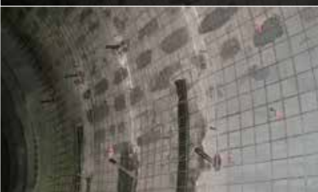
Anclajes permanentes
