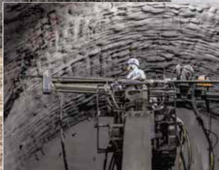
Bulones Anclajes radiales
