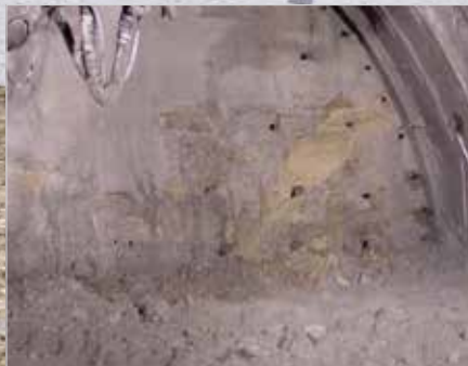
Anclaje de frente de excavación
