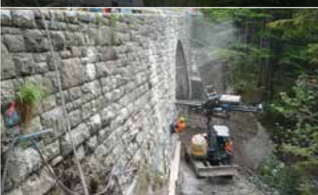
Estabilización de muros de contención
