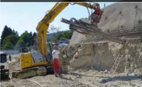
Estabilización de muros de contención
