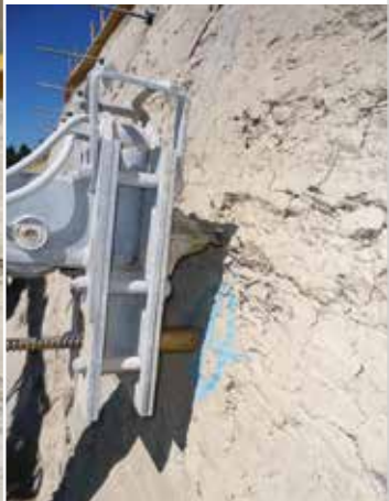
Alineación exacta del mástil de perforación en el punto de entrada.
