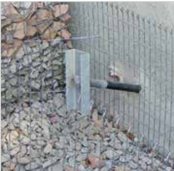
Estabilización de un desnivel en el terreno mediante muros de gaviones anclados.
