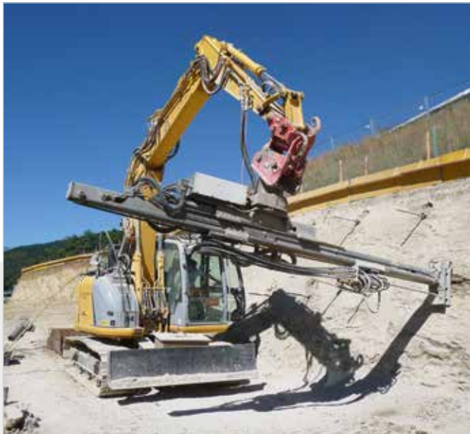
Alineación exacta del mástil de perforación en el punto de entrada.
