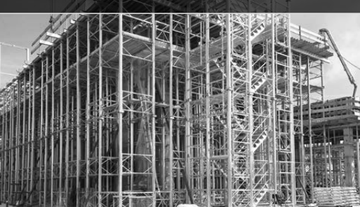
Sistemas de Encofrado
