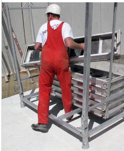
La imagen muestra la versión antigua de la jaula de almacenamiento de paneles.
