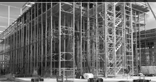
Sistemas de encofrado
