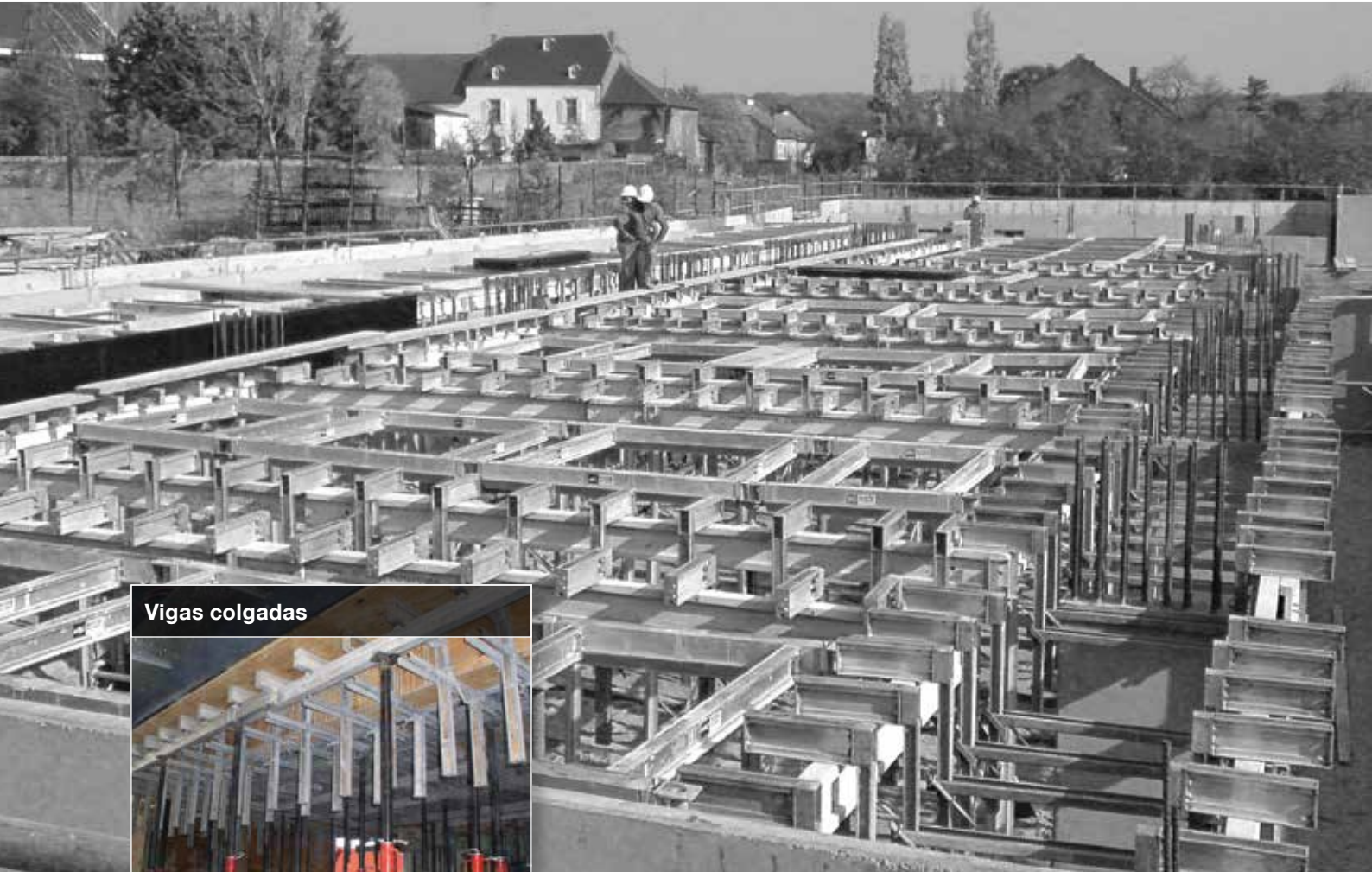
Escalonados de losa
