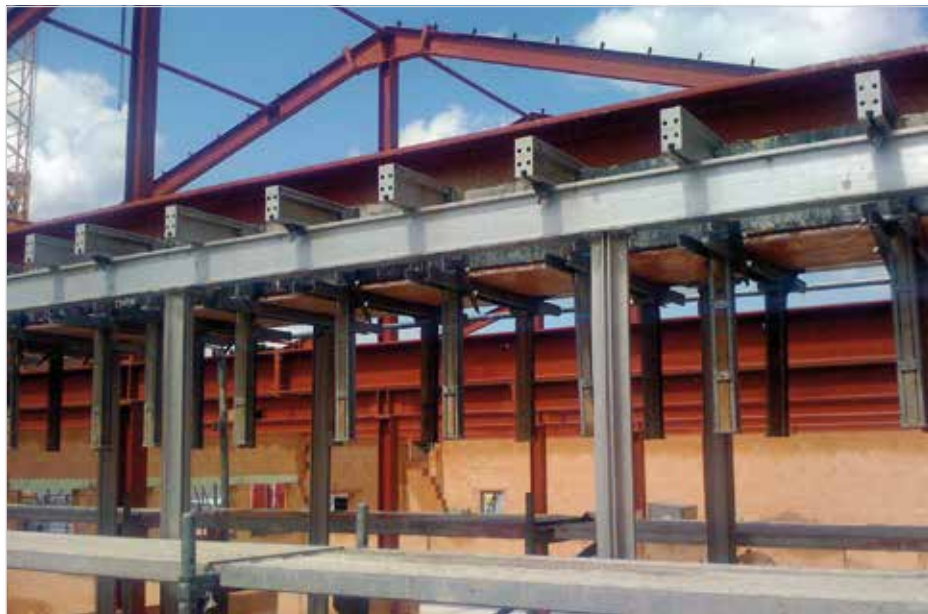
Viga de cuelgue con zunchos U-HV sobre encofrado de losa ALU-Flex con vigas de aluminio TITAN 225.
