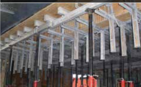
Escalonados de losa
