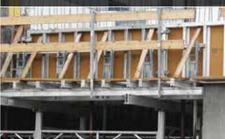
Vigas en T y vigas perimetrales
