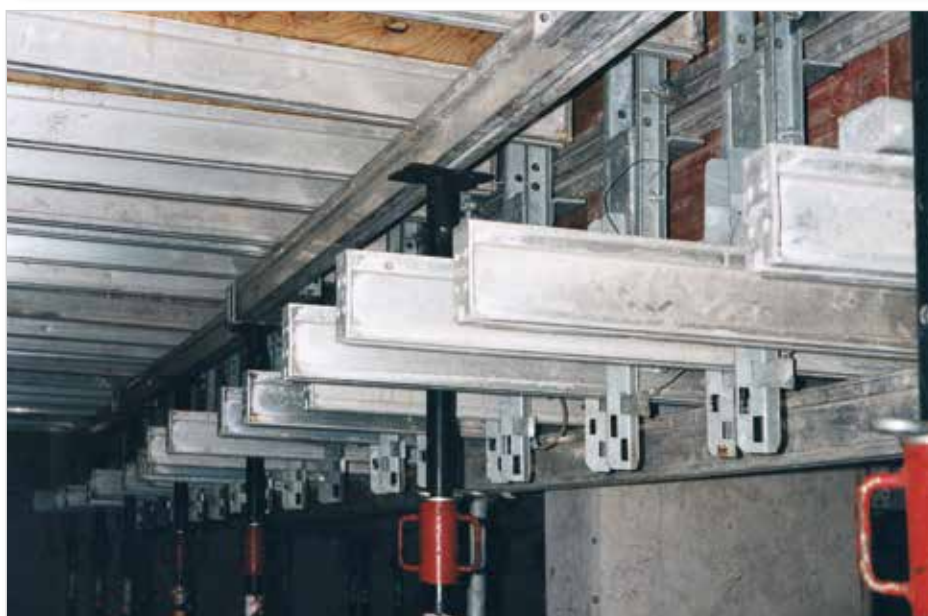
Escalonado de losa resuelto con bastidor para viga de cuelgue sobre encofrado de losa ALU-Flex.
