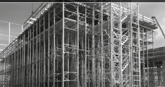
Sistemas de Encofrado
