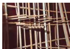
Antes de hormigonar
