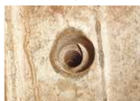
Imagen del hormigón tras recuperar el anclaje
