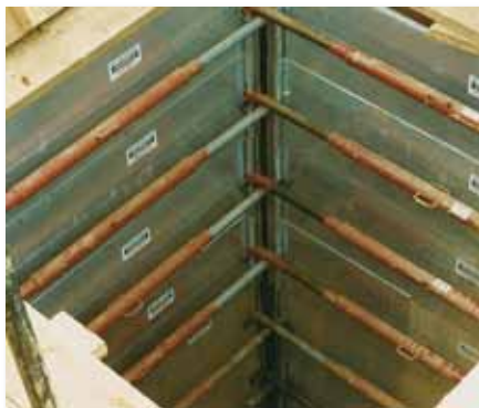
Solución especial: Entibación de pozo con codales adicionales
