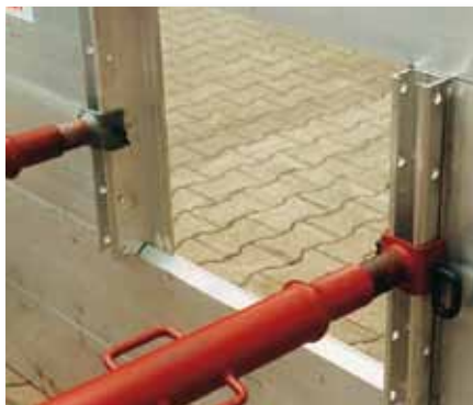
Solución especial: Blindaje de aluminio con 'ventana' 0,54 x 0,5 m²
