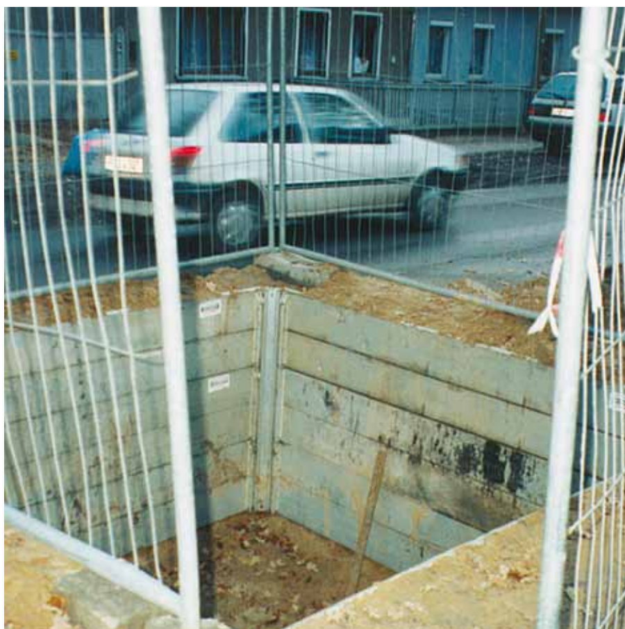
Renovación de acometidas
