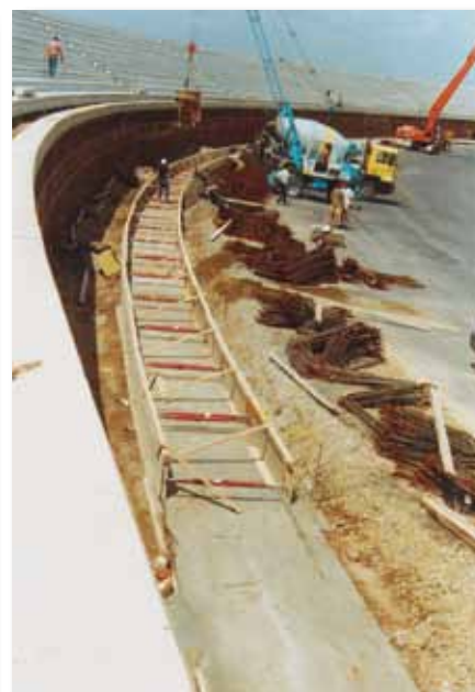
Paneles Alu utilizados como encofrados para fundaciones
