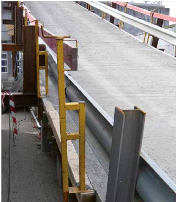
Protección de un acceso a una obra con portabarrandillas TITAN H
