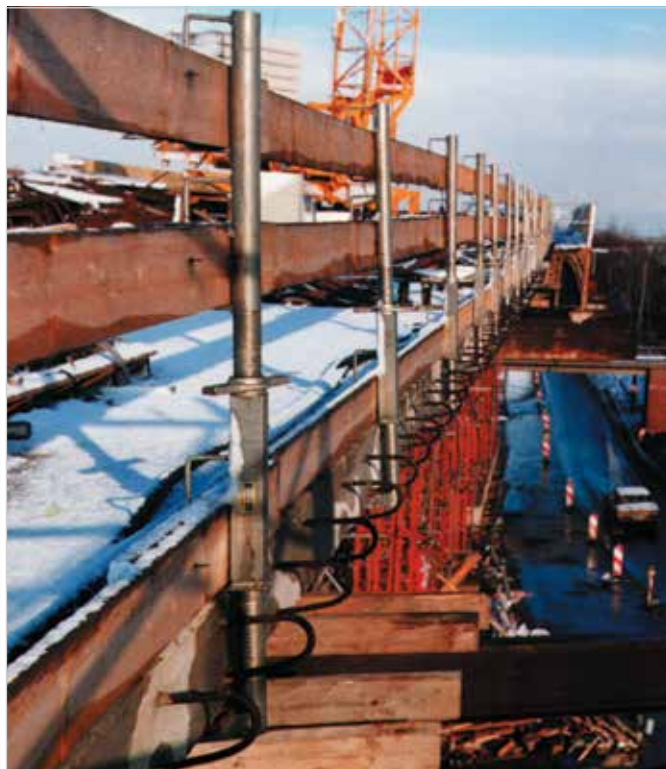
Protección del borde de una losa con portabarrandillas TITAN HS
