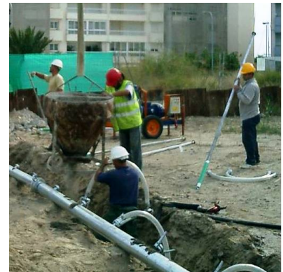
RELLENO Y CONEXIÓN
