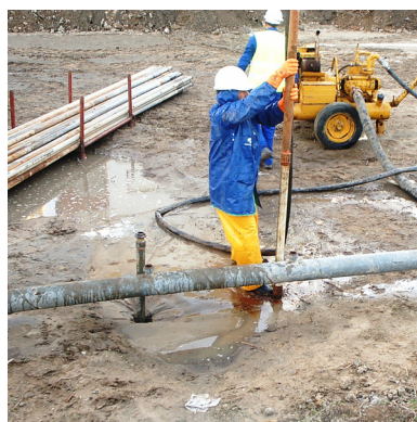
HINCA CON AGUA A PRESIÓN
