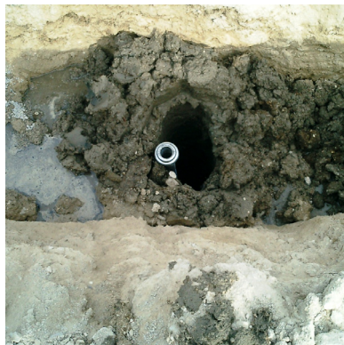
LANZA COLOCADA EN EL POZO
