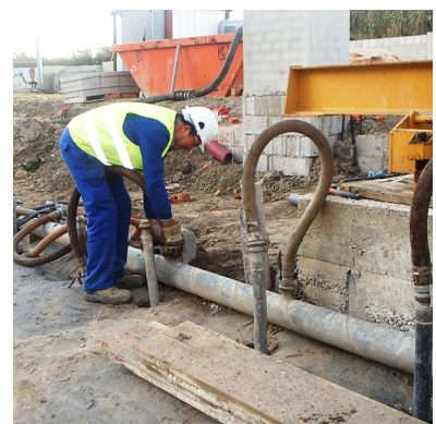
CONEXIÓN A COLECTOR
