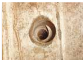
Imagen del hormigón tras recuperar el anclaje
