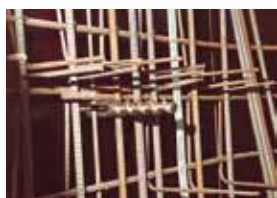
Antes de hormigonar
