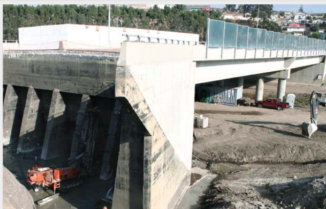
Recalce de un estribo de puente con 40 micropilotes TITAN 103/78 en una zona de alto riesgo sísmico de Chile en el año 2009.
