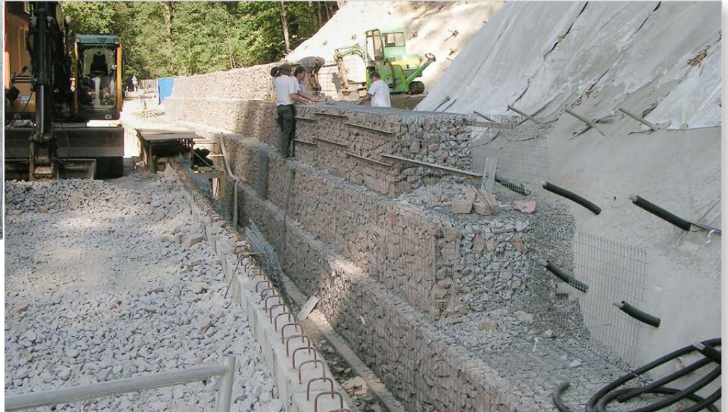
Estabilización de un desnivel en el terreno mediante muros de gaviones anclados.
