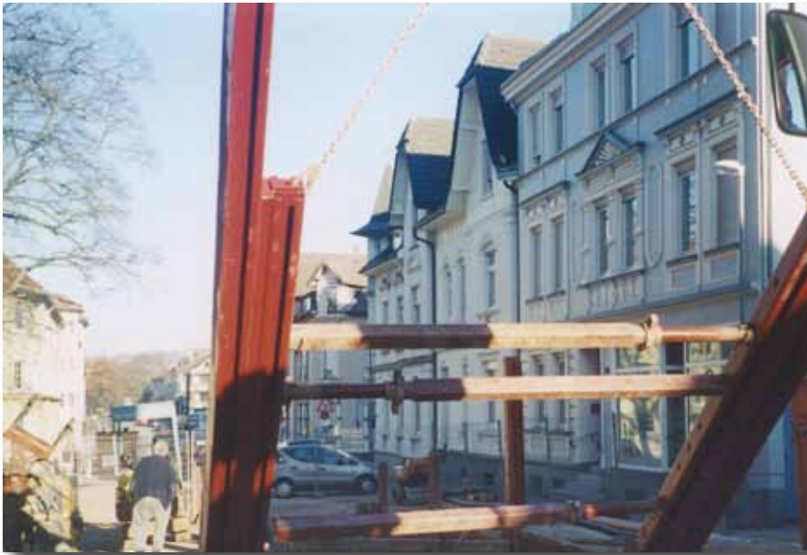
El ojal para transporte con cuña situado en la guía interior más corta, permite un punto de izado con menor altura
