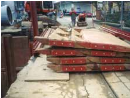
Paneles de entibación y paneles cortantes con patines deslizantes atornillados
