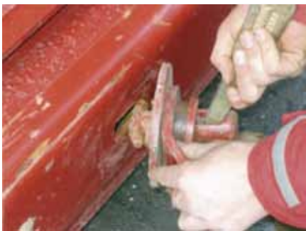
Montaje del ojal para transporte
