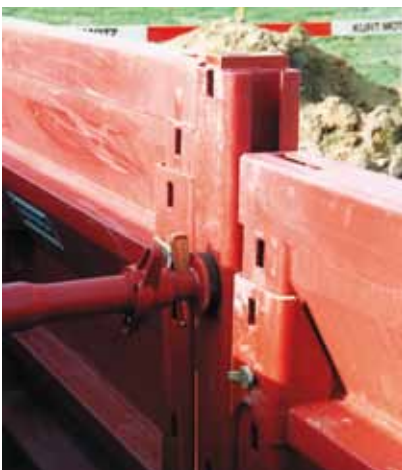
La guía deslizante amplía la distancia en planta de los codales 250 mm. Así pueden colocarse tubos de 3.50 m de longitud fácilmente cuando se usan paneles de 4.00 m de largo.
