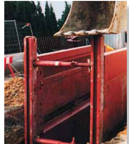
La guía deslizante va bajando a medida que va progresando la excavación.
