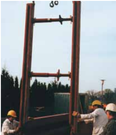
Un módulo de paneles y codales se sitúa en una preexcavación realizada en la zanja y sirve como punto de partida para insertar la primera guía deslizante.
