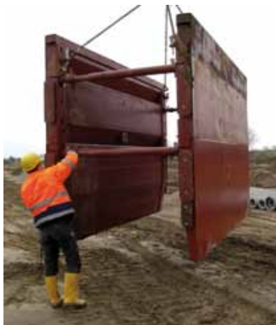
Los codales se pueden colocar en la guía deslizante o en los paneles. De este modo se puede evitar el uso de guías al principio y al final de la zanja.
