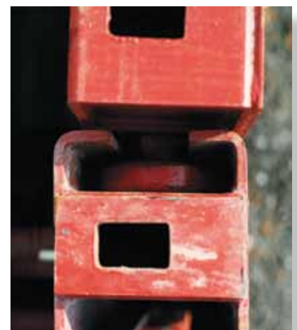
Detalle de la solidez con que se fabrica la guía deslizante y del orificio en la parte superior de la misma para enganchar la eslinga. Rodamientos o patines fuertes y bien acoplados.
