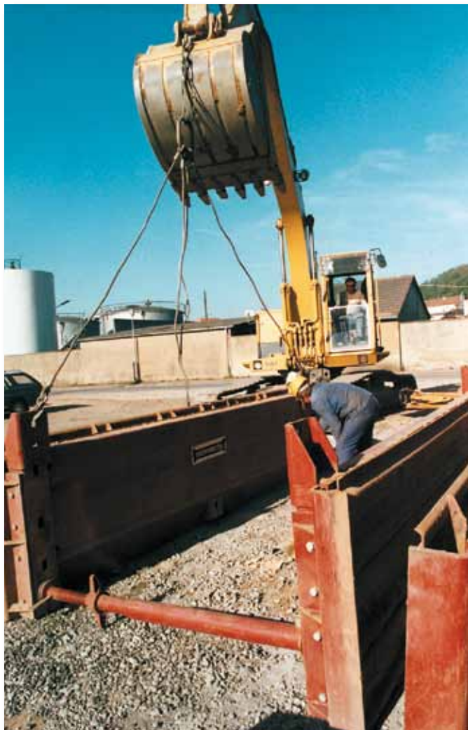
1 Izado de las planchas con cámara KP y colocación de los codales Gi-P.
