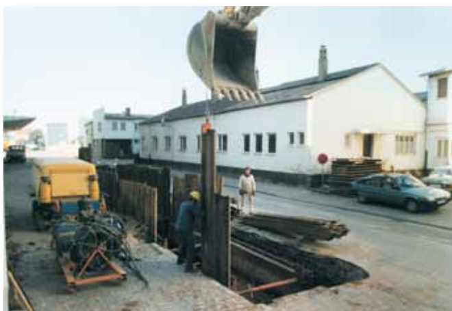
4 Enganche de las tablestacas con la pinza, izado y posicionamiento vertical de las mismas, sobre las guías de la plancha con cámara.
