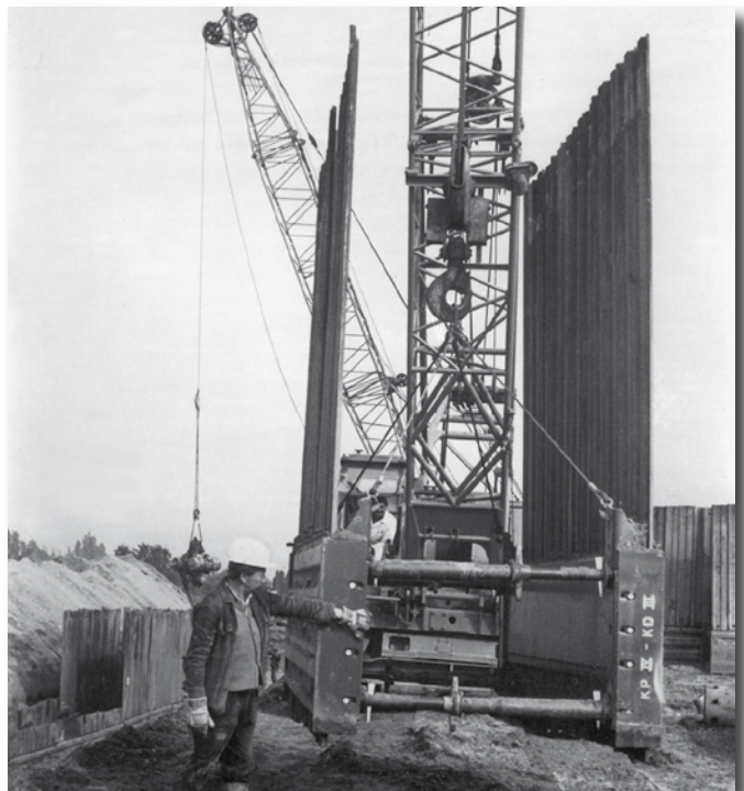
11 Traslado de una unidad de blindaje, tablestacas incluidas, con una máquina capaz de mover una carga de 4,3 t. Una RH 9, por ejemplo, engancha y transporta un módulo de blindaje, por delante.
