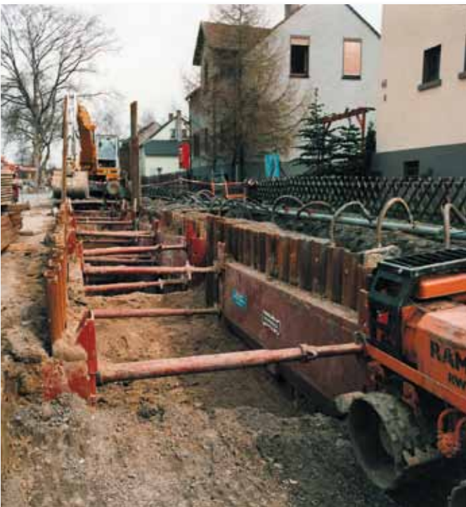
10 Relleno y compactación.
