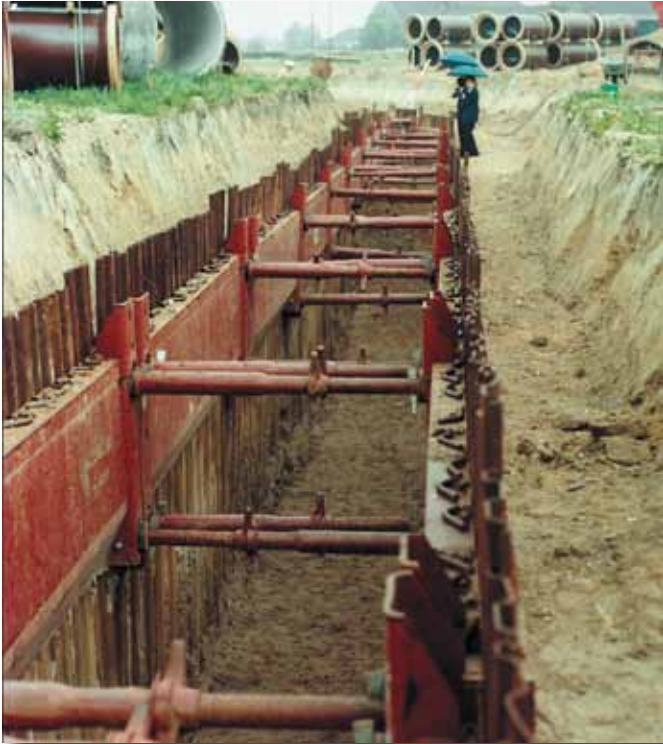
8 Las formas lisas y sin bordes salientes ó cortantes de las planchas con cámara KP facilitan la excavación.
