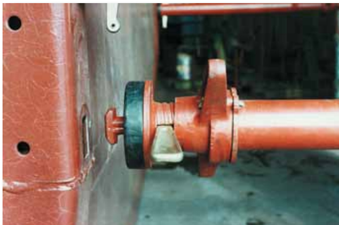
2 Montaje de los codales: introducir la cabeza de martillo del perno del codal, en el agujero rasgado, girar y fijarlo de un martillazo en la cuña.
