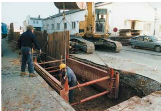
3 Colocación del módulo de blindaje en la excavación previa, de 1,5 m de profundidad.
