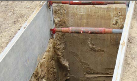
Sistema de entibación ligera de aluminio GIGANT para zanjas
