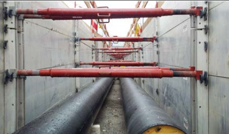
Sistema de entibación ligera de aluminio con cámara
