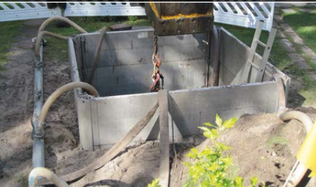
Sistema de entibación ligera de aluminio GIGANT para pozos
