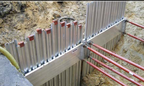
Sistema de entibación ligera de aluminio GIGANT para pozos
