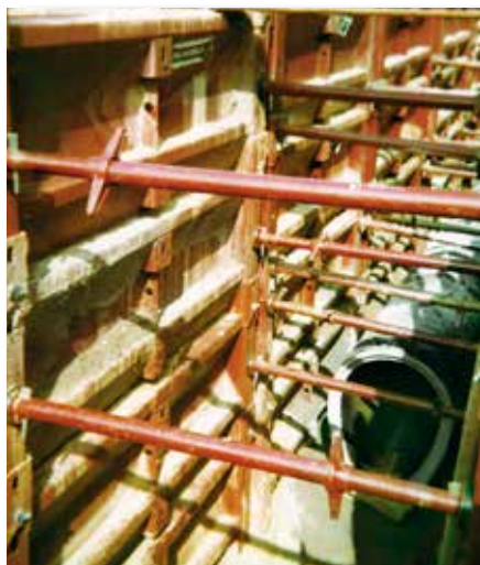
Zanja de 4,0 m. de profundidad. Paneles de 4,0 m. de longitud acodadas en los extremos, altura libre entre suelo y codales de 1,5 m.
