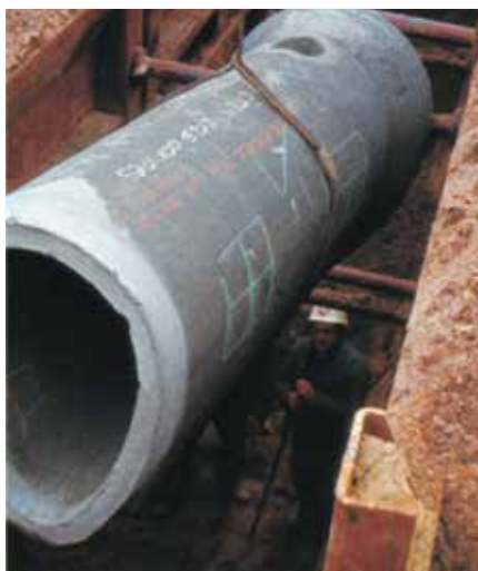
Los tubos de 2,5 m. ó de 3,5 m, de longitud se colocan sin necesidad de mover los codales.
