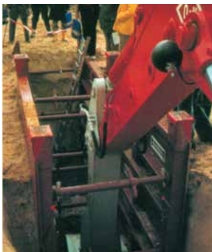
Trabajo de la excavadora entre los codales.
