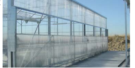
◀ SARAN PENCERE Plastik film ana eksen üzerinde aşağı yukarı sarmaktadır. GİYOTİN PENCERE ▶ Dikine hareket ile açılır.
