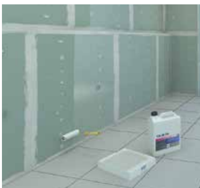
CORRECTO: IMPRIMADOR DE PAREDES
