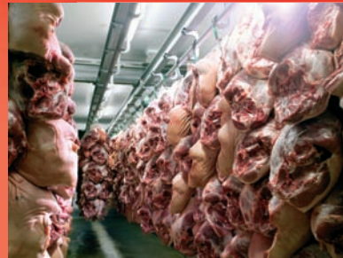
● Cámara estabilización jamones ● Ham stabilization room
