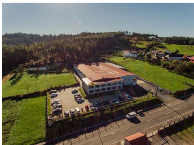
Oficinas y almacén ( Matalobos-A Estrada).
