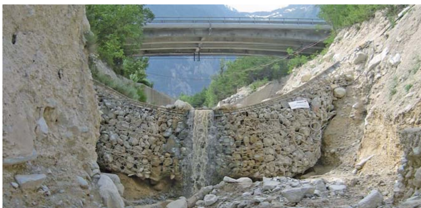
La barrera flexible con red de anillos de Geobrugg poco después de su montaje (arriba), y tras la sexta avalancha (abajo): la misma ha superado la prueba de carga en todos los aspectos.
