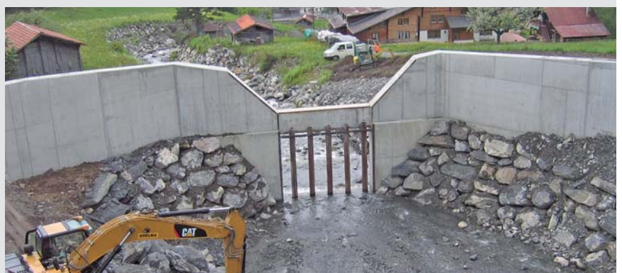
Foto: Herzog Ingenieure AG, Davos Suiza
