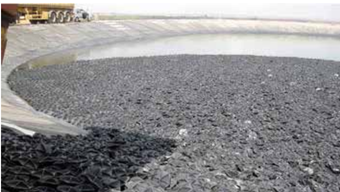
La cubierta flotante Hexa-Cover® BULK: entrega e instalación
