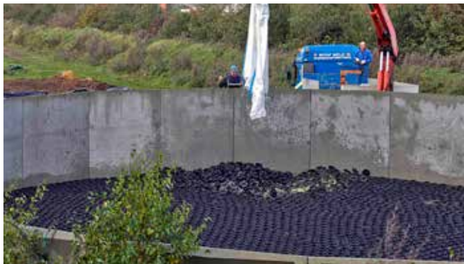
La cubierta flotante Hexa-Cover® Big Bags: entrega e instalación
