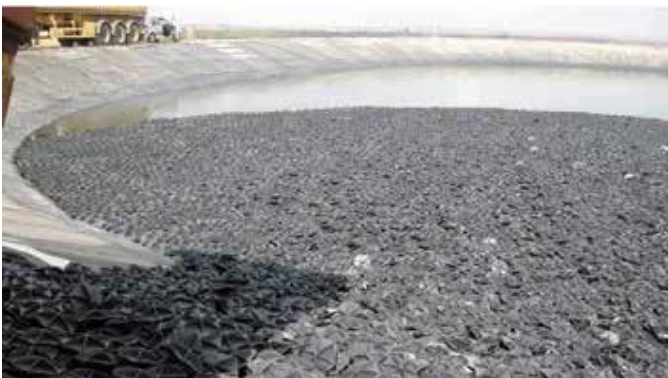
BULK: entrega e instalación
