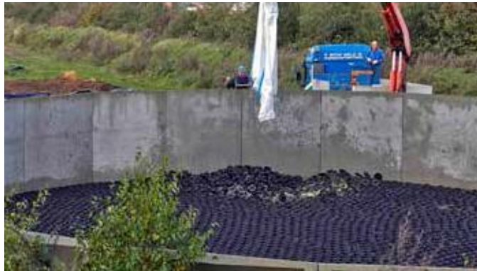
Big Bags: entrega e instalación
