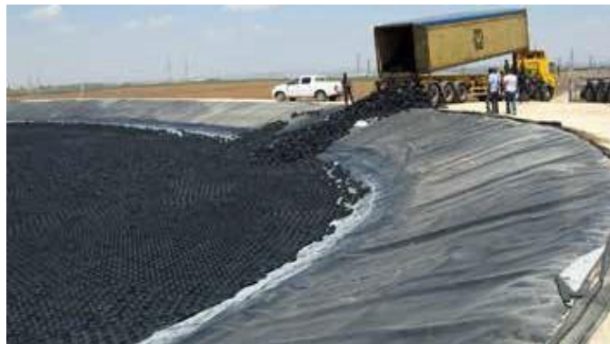
BULK: entrega e instalación
