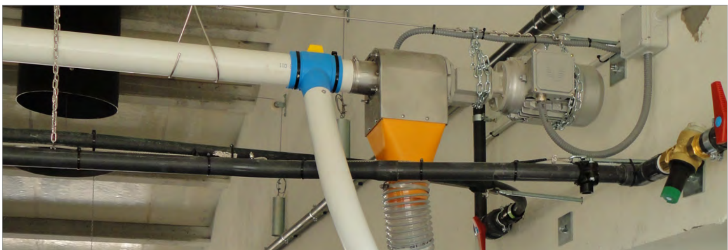
Grupos de tracción contruidos con materiales anticorrosivos, con unidad de control de gran diámetro que evita los apelmazamientos
