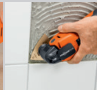
El rascador de metal duro alisa la cola de baldosas y provee una base plana.
