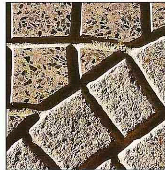
Particolare zona granigliata e non. Detail of shot blasted surface and non blasted area. Detail von gestrahlter und nicht gestrahlter Zone. Détail zone grenailée et non grenailée.
