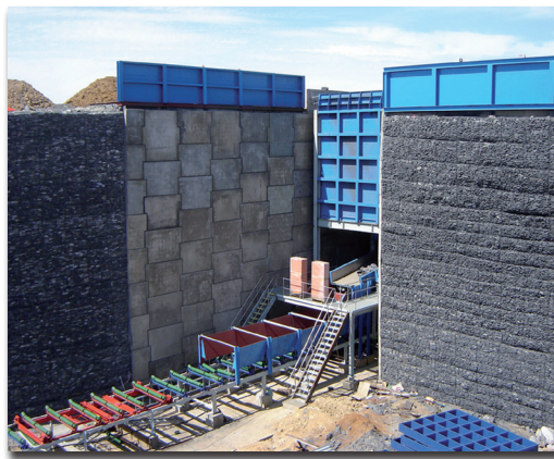
Muro de vertedero ejecutado con MacRes® y Terramesh™ Optimum Colliery, Sudáfrica
