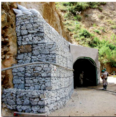
Muros de gaviones Mina Poderosa, Peru
