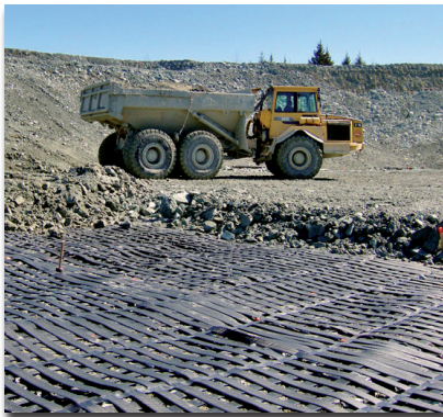
Refuerzo basal con geomallas Paralink™ en zonas de acopio. Goldex Mine, Canada
