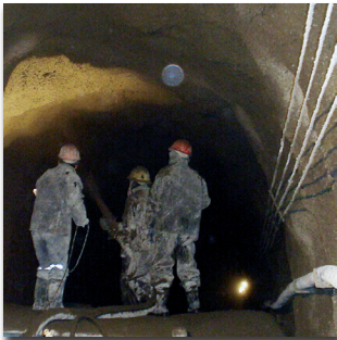
Gunita reforzada con fibras metálicas Wirand Pillones, Peru
