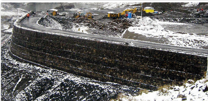
Lavadero ejecutado con Terramesh™
