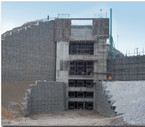
Muro de terreno reforzado Terramesh™ Mina Iduapriem, Ghana
