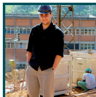
Soporte técnico a pie de obra
