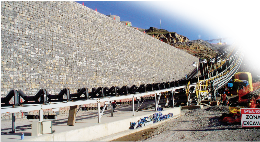
Muro de terreno reforzado Terramesh™ Mina Gold Field, Perú
