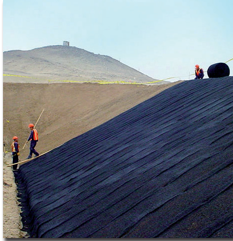
Protección contra la erosión superficial, Perú
