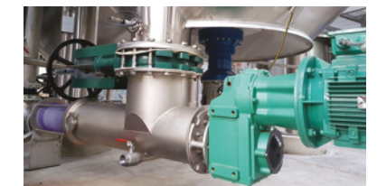
PHC: bomba bajo cuba con brida
