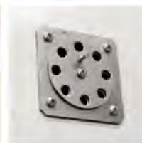
Ventilas externas para conexión de sistemas de ventilación forzada.
