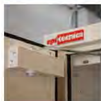
Sistema de cierre automático por temperatura, con bloqueo de puertas abiertas.
