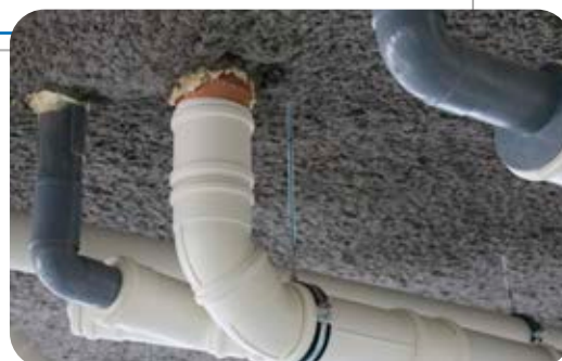
Figura 8. Conexiones entre columnas de desagüe y ventilación en la base de la edificación
