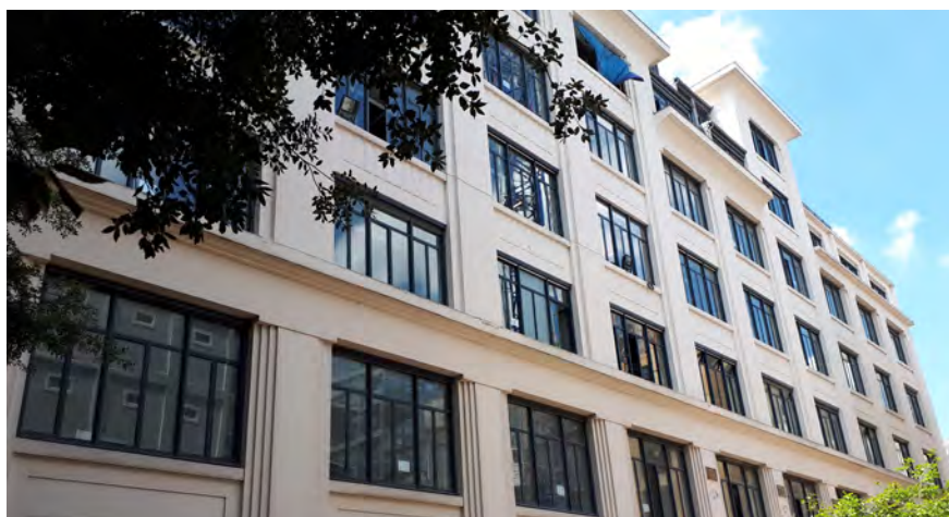
Réhabilitation et construction bâtiment Breteuil-Séguir, Paris 7ème (75)
