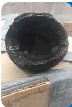
Coupe de tube de 110 mm prélevée sur les tuyaux de descente concernés
