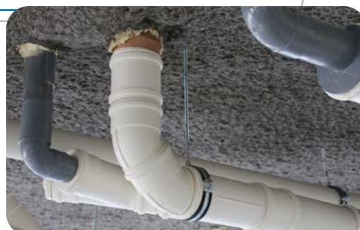
Figure 8. Connexions entre les colonnes d'évacuation et de ventilation à la base du bâtiment.
