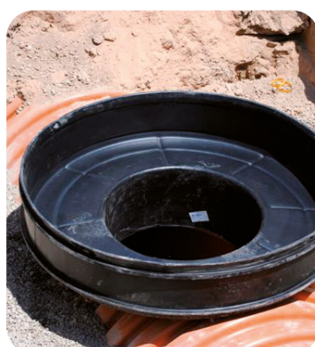
Instalación del cuerpo con base de registro
