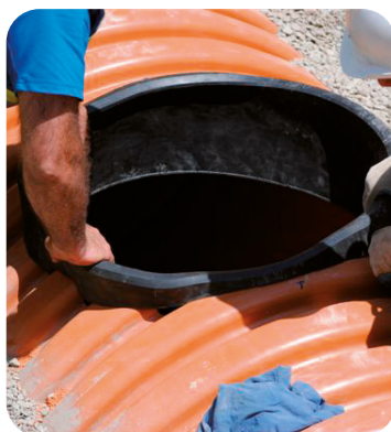
Instalación del cuerpo con base de registro
