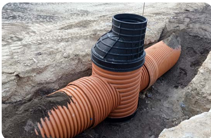
Instalación pozo prefabricado soldados con base ciega
