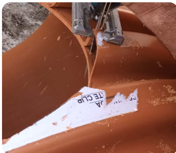
Secuencia de instalación de un clip elastomérico
