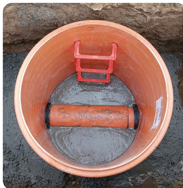
Ejecución de acometidas realizadas in situ
