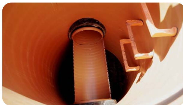
Secuencia de instalación de un clip elastomérico
