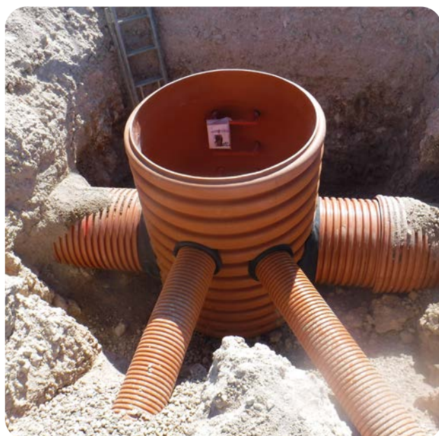
Ejecución de acometidas realizadas in situ
