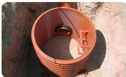
Acabado del fondo del pozo rematado con hormigón (solamente recomendable sin freático)
