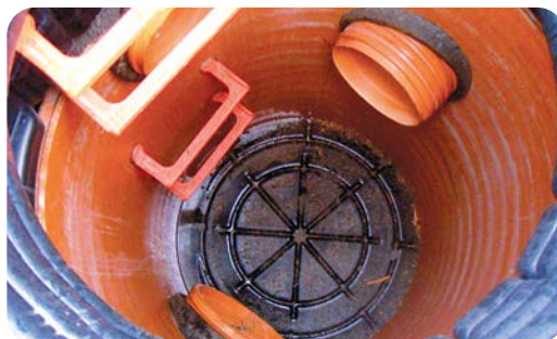
Acabado del fondo del pozo con base estanca (necesario con freático)
