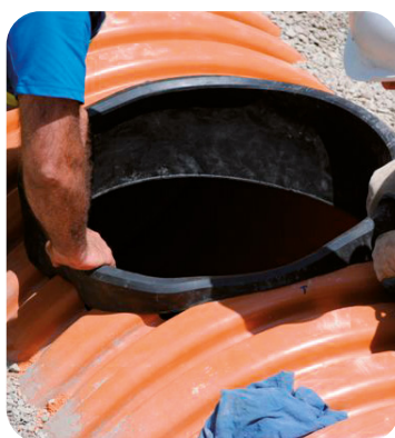
Installation du corps avec fond du regard
