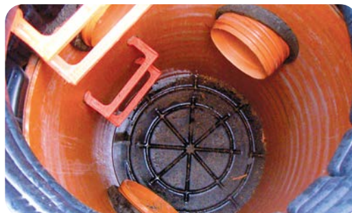
Finition du fond du regard avec base étanche (nécessaire avec nappe phréatique)
