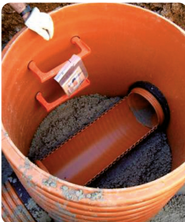
Finition intérieure d'un regard à 180°
