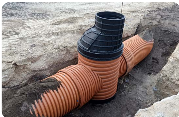
Installation regard préfabriqué soudé avec base pleine
