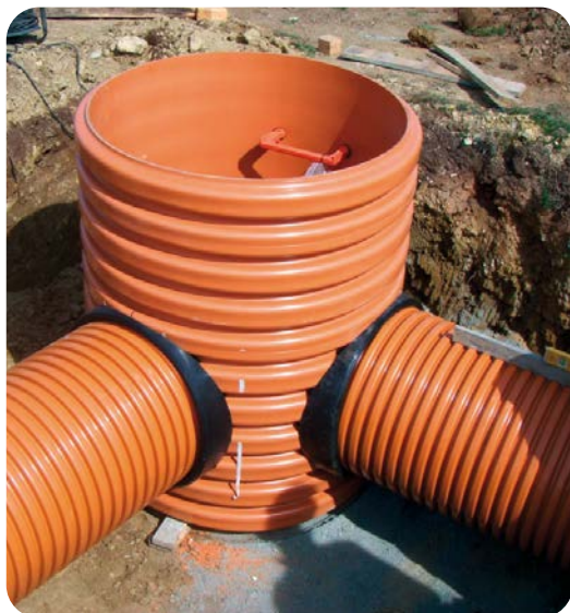
Installation de regards dans les collecteurs avec changement de direction
