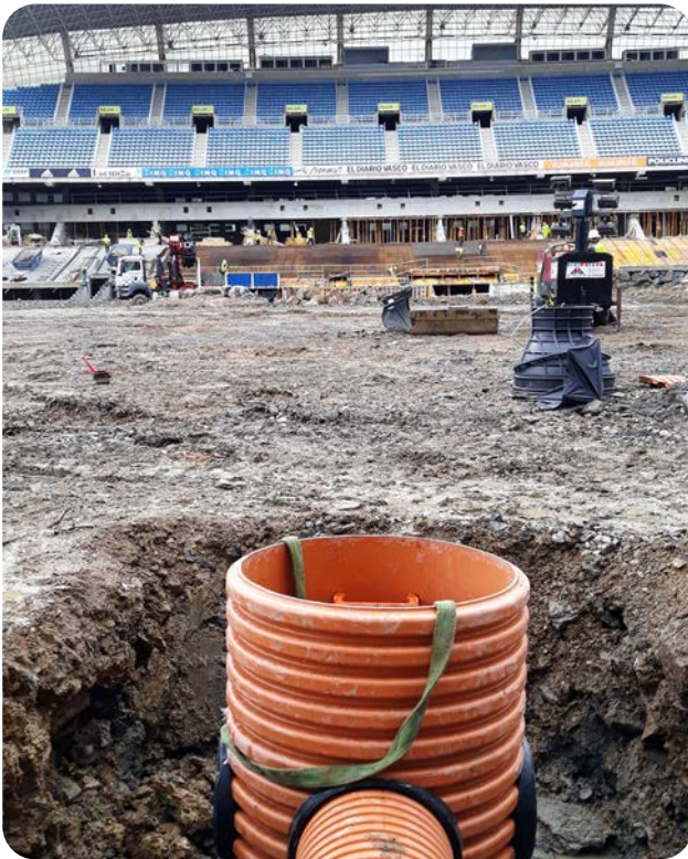
Réseau de drainage du terrain de football d'Anoeta (Saint-Sébastien)
