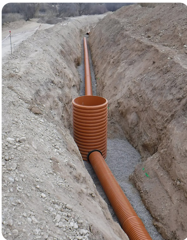
Station d'épuration de Maella (Saragosse)
