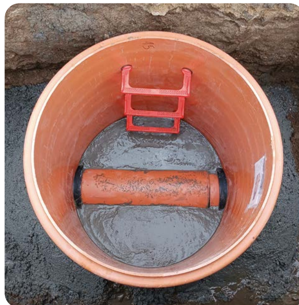
Exécution de raccordements in situ
