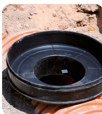
Installation du corps avec fond du regard
