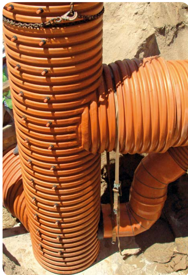
Regard pour réseau gravitaire avec le système de regards SANECOR®
