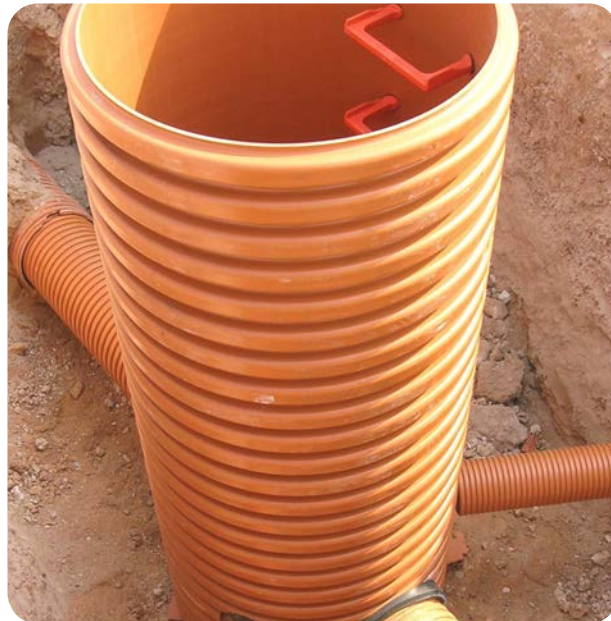
Le corps du regard SANECOR® est fabriqué à partir de tuyaux SANECOR® SN8
