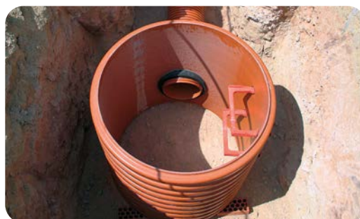
Finition du fond du regard en béton (recommandé uniquement sans nappe phréatique)
