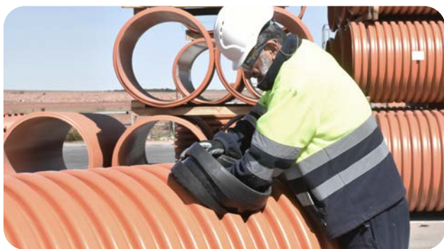
Séquence d'installation d'un clip en élastomère
