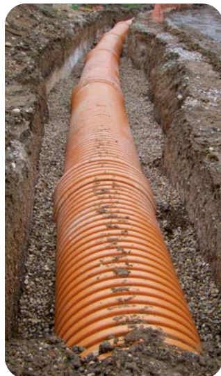
La flexibilidad de las tuberías plásticas es importante para absorber desplazamientos del terreno
