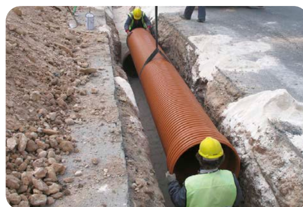
Manipulación en obra del tubo SANECOR®
