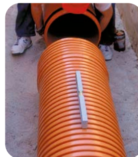
Izda., montaje de tuberías SANECOR® con medios mecánicos discretos (diámetros medios y grandes). Dcha., unión manual (diámetros pequeños)
