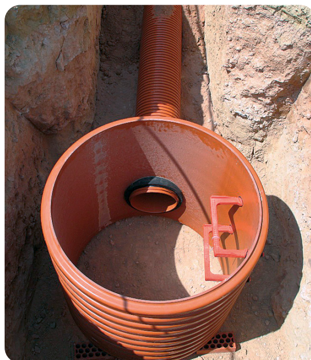
Hormigonado del fondo del pozo SANECOR® 1ª fase
