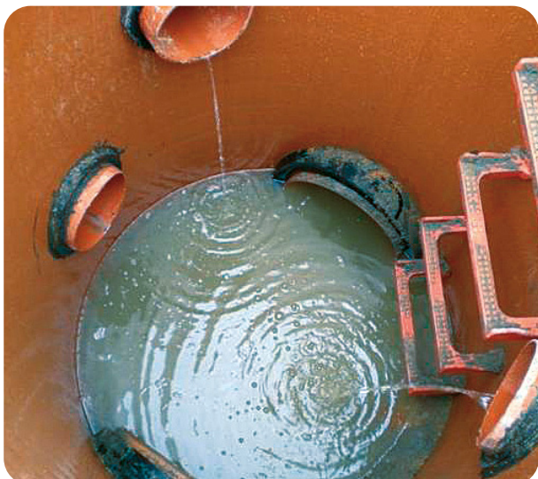
Realización de múltiples acometidas realizadas in situ
