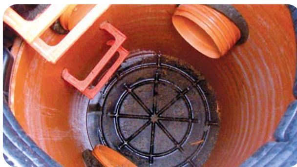
Acabado del fondo del pozo con base estanca
