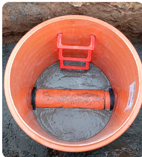
Hormigonado del fondo del pozo SANECOR® 2ª fase
