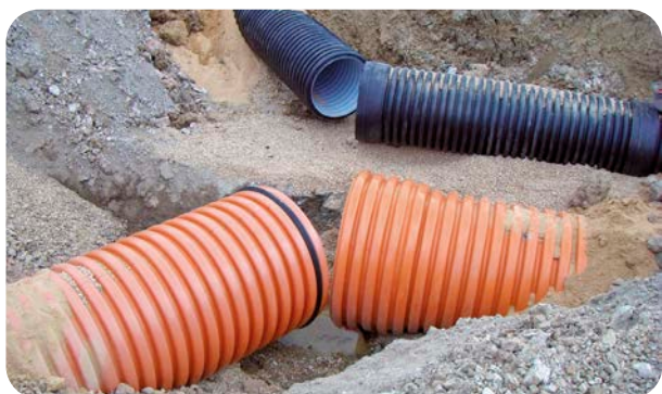
Tuberías de PVC corrugado (color teja) y de PE corrugado (color negro)
