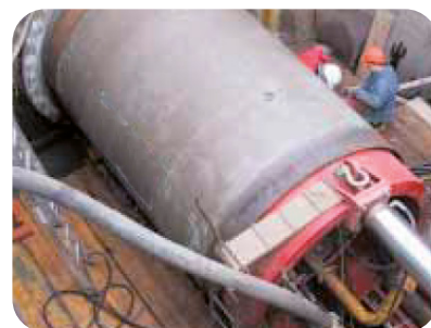
Hormigón polímero (tuberías de hinca)
