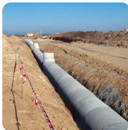
Colector de hormigón armado
