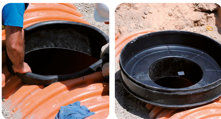
Instalación del cuerpo con base de registro
