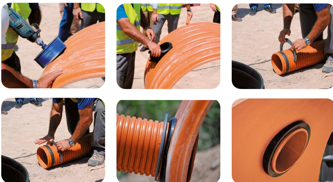
Secuencia de montaje de pieza tope para las acometidas SANECOR®
