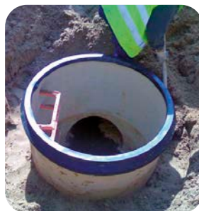
Pozos de registro en materiales plásticos (poliéster y polietileno)
