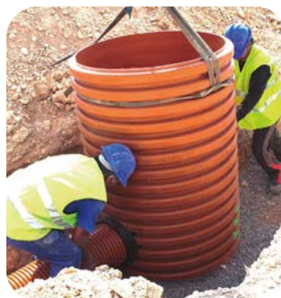
Instalación de tuberías al cuerpo del pozo
