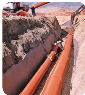
Izda., montaje de tuberías SANECOR® con medios mecánicos discretos (diámetros medios y grandes). Dcha., unión manual (diámetros pequeños)
