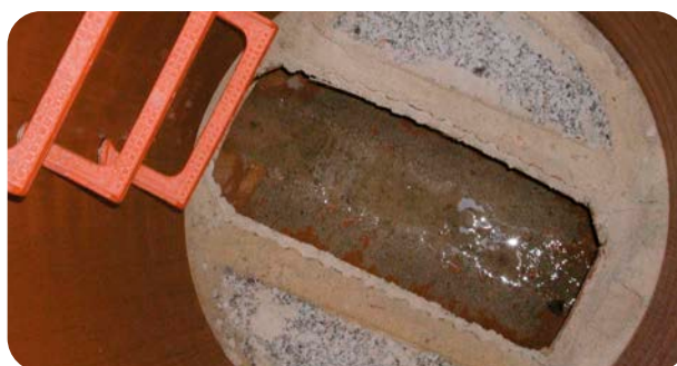
Interior del pozo con base estanca
