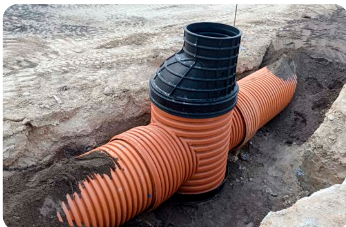
Instalación pozo prefabricado soldados con base ciega
