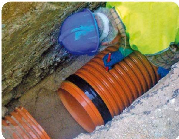
Conexión manual de tubería corrugada
