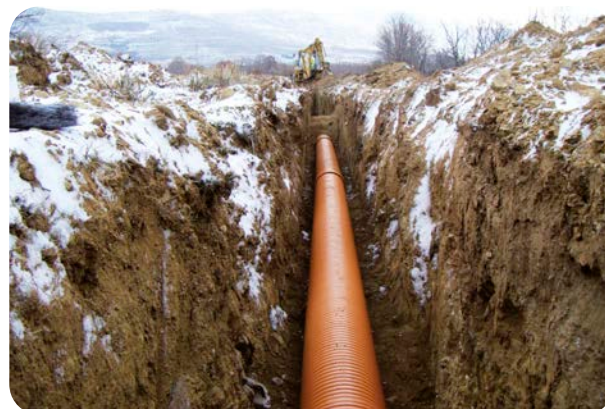
Vista de tubería SANECOR® instalada en la zanja
