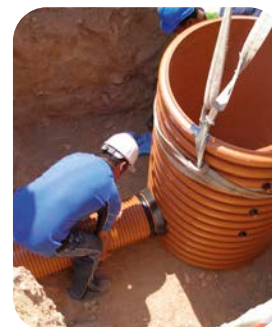
Instalación de tuberías al cuerpo del pozo
