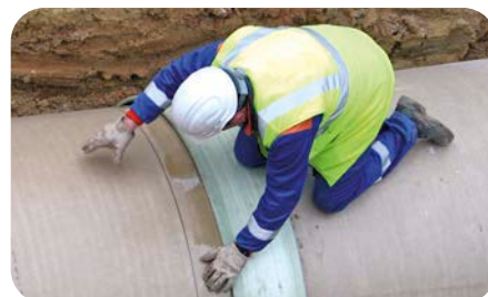
Unión por manguito en tuberías de PRFV de gran diámetro
