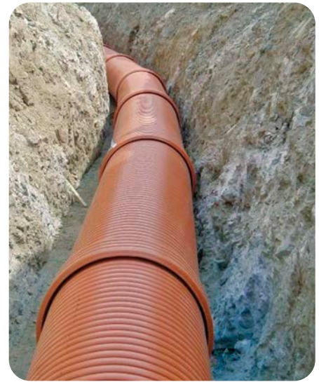
Tubería SANECOR® de 1.200 mm con desviación angular
