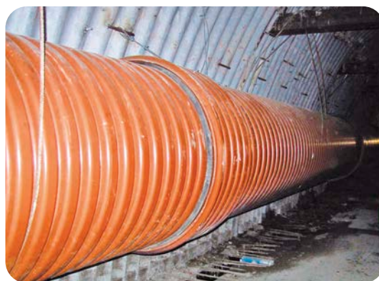
Instalación de tuberías SANECOR® en zanja y en galería
