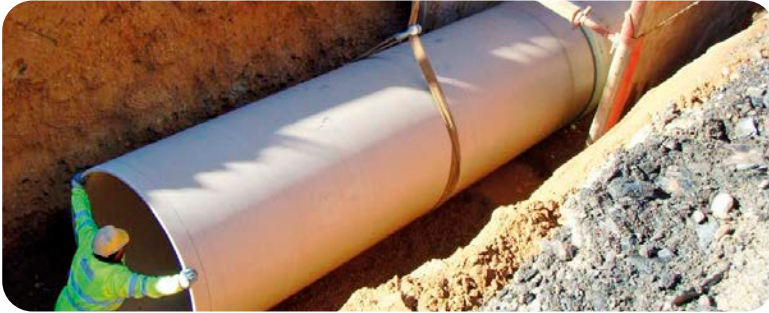
Montaje de tubos de PRFV en zanja entibada
