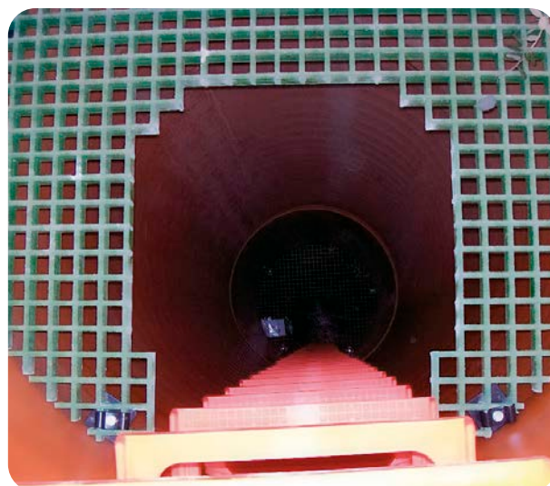
Tramex de poliéster en pozos SANECOR®
