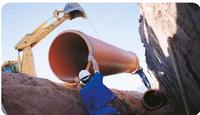
Instalación de tuberías SANECOR® en zanja y en galería
