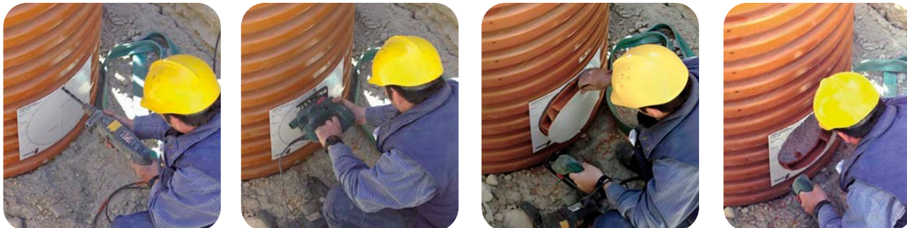
Procedimiento de perforación de taladros para inserción de clips elastoméricos
