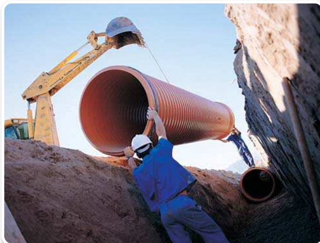
INSTALACIÓN DE TUBERÍAS adecuada SANECOR® EN GALERÍA Y EN ZANJA.
