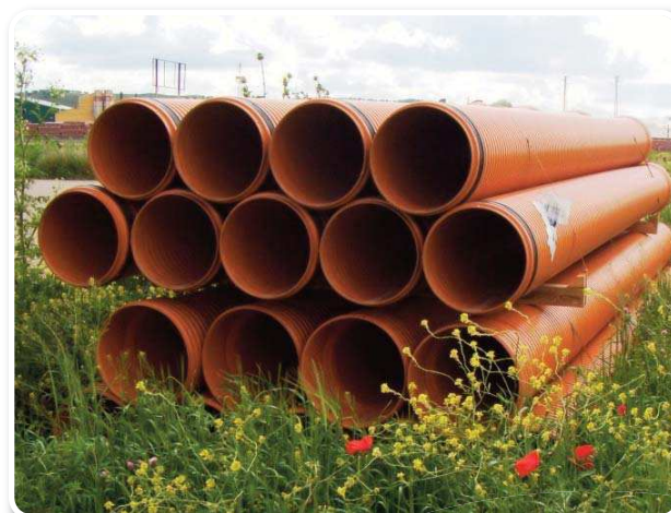
ACOPIO TUBERÍA adecuada SANECOR®.
