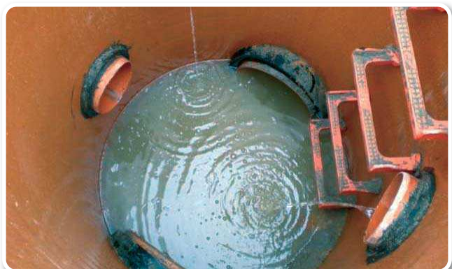
REALIZACIÓN DE MÚLTIPLES ACOMETIDAS REALIZADAS IN SITU.
