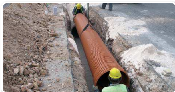
MANIPULACIÓN EN OBRA DEL TUBO adequa SANECOR® .
