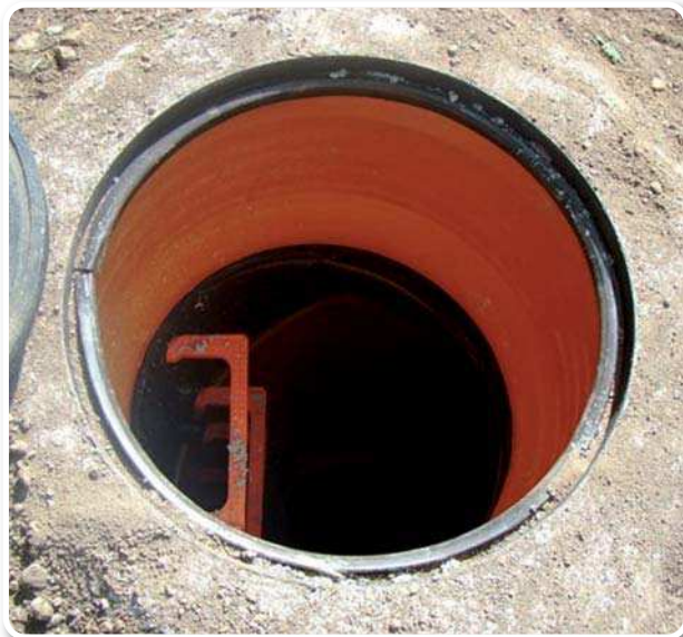
CORONACIÓN DEL POZO.
