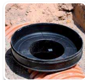
INSTALACIÓN DEL CUERPO CON BASE DE REGISTRO.
