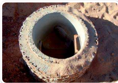
POZOS DE REGISTRO EN MATERIALES CONVENCIONALES (HORMIGÓN Y LADRILLO). A LA DERECHA, ANILLOS PREFABRICADOS DE HORMIGÓN.
