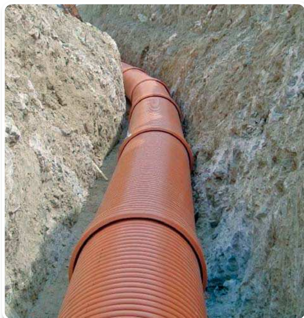
TUBERÍA adecuada SANECOR® DE 1200 mm CON DESVIACIÓN ANGULAR.
