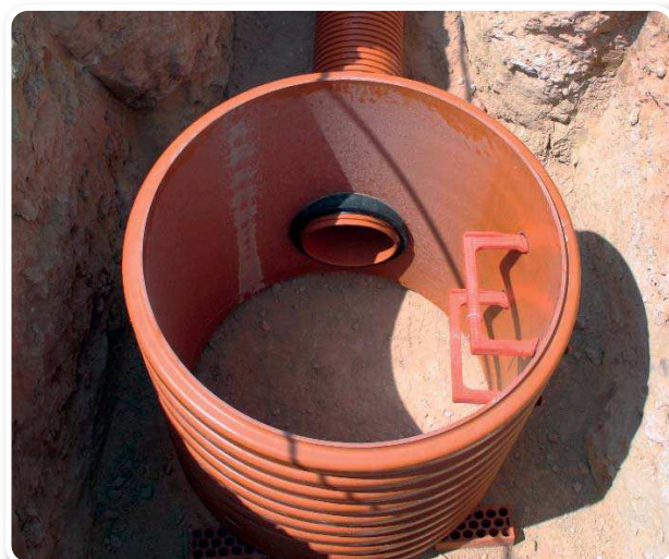
HORMIGONADO DEL FONDO DEL POZO. 1ª FASE.
