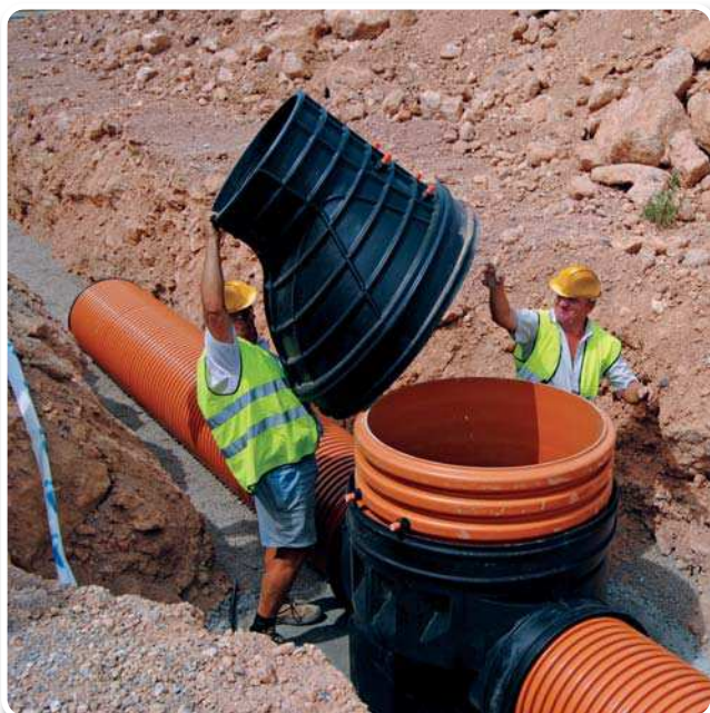
INSTALACIÓN DE PIEZA ENTRONQUE DE PASO TOTAL.
