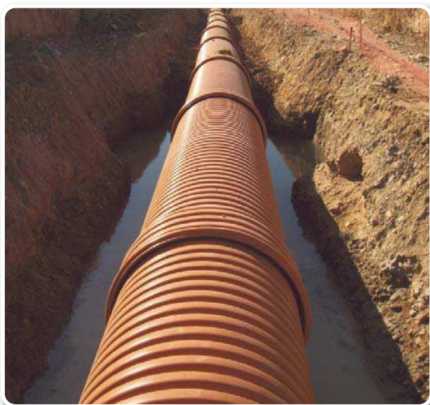
COLECTOR DE PVC CORRUGADO SN8.
