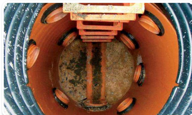
REALIZACIÓN DE MÚLTIPLES ACOMETIDAS REALIZADAS IN SITU.
