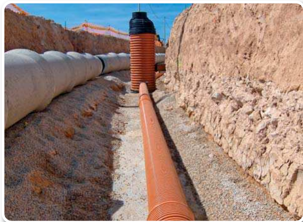
COLECTOR Y POZOS adecuada SANECOR® PARA AGUAS RESIDUALES JUNTO A COLECTOR DE PLUVIALES EN HORMIGÓN.
