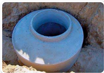
POZOS DE REGISTRO EN MATERIALES CONVENCIONALES (HORMIGÓN Y LADRILLO). A LA DERECHA, ANILLOS PREFABRICADOS DE HORMIGÓN.
