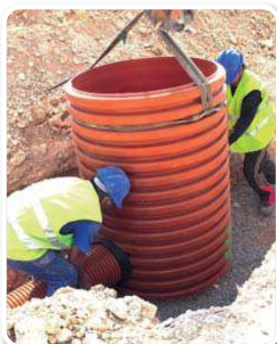
INSTALACIÓN DE TUBERÍAS AL CUERPO DEL POZO.
