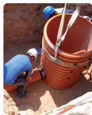
INSTALACIÓN DE TUBERÍAS AL CUERPO DEL POZO.
