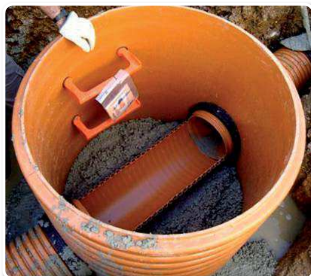
HORMIGONADO DEL FONDO DEL POZO. 2ª FASE
