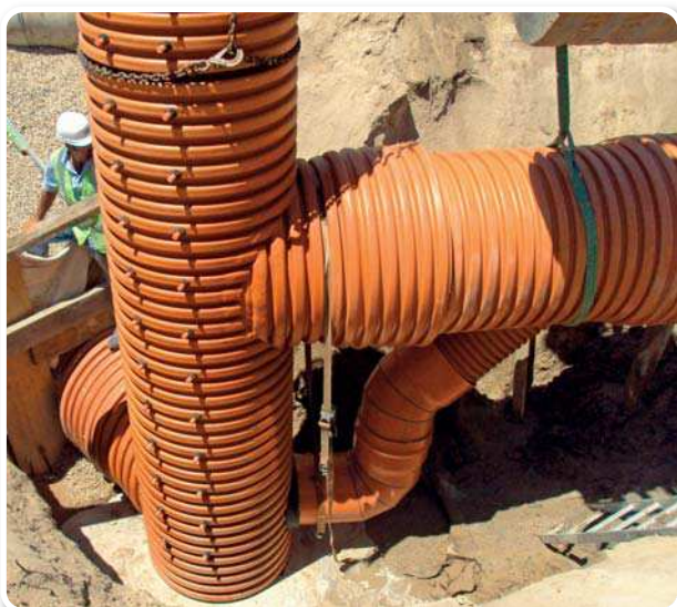
POZOS DE RESALTO CON EL SISTEMA DE POZOS adequa SANECOR® (A LA IZDA. TIPO MADRID).
