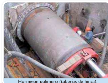
Hormigón polímero (tuberías de hinca).
