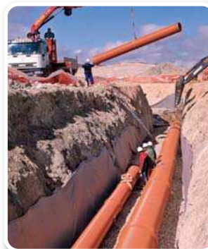
A LA IZDA., MONTAJE DE TUBERÍAS adequa SANECOR® CON MEDIOS MECÁNICOS DISCRETOS (DIÁMETROS MEDIOS Y GRANDES). A LA DCHA., UNIÓN MANUAL (DIÁMETROS PEQUEÑOS).
