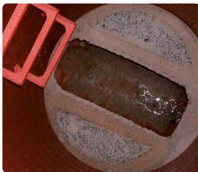
INTERIOR DEL POZO CON BASE ESTANCA.
