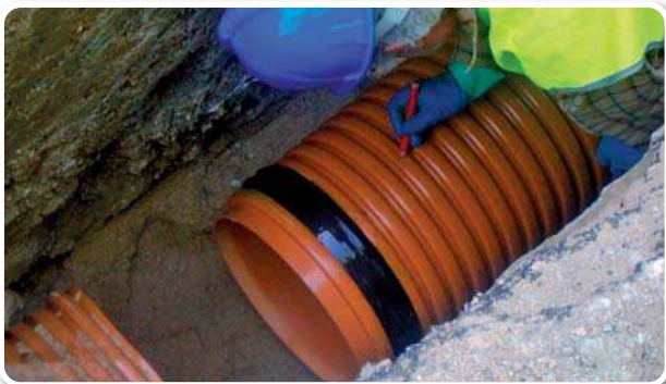
CONEXIÓN MANUAL DE TUBERÍA CORRUGADA.
