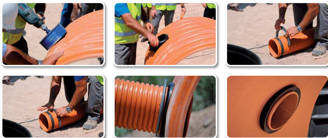
SECUENCIA DE MONTAJE DE PIEZA "DIADEMA" PARA EL TOPE DE LAS ACOMETIDAS adequa SANECOR®.
