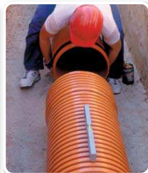
A LA IZDA., MONTAJE DE TUBERÍAS adequa SANECOR® CON MEDIOS MECÁNICOS DISCRETOS (DIÁMETROS MEDIOS Y GRANDES). A LA DCHA., UNIÓN MANUAL (DIÁMETROS PEQUEÑOS).
