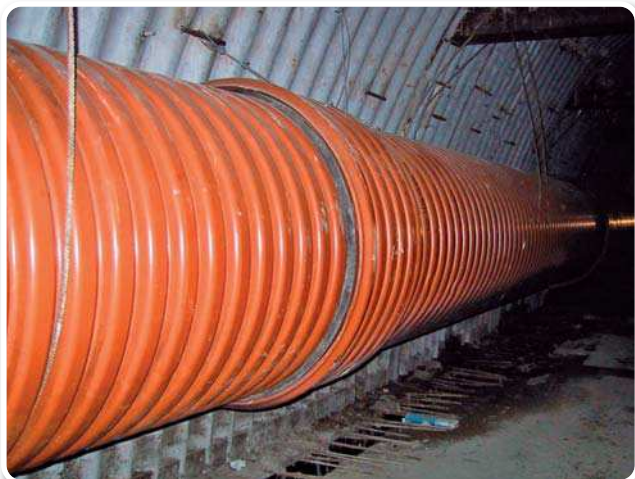
INSTALACIÓN DE TUBERÍAS adecuada SANECOR® EN GALERÍA Y EN ZANJA.
