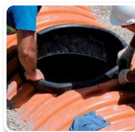
INSTALACIÓN DEL CUERPO CON BASE DE REGISTRO.
