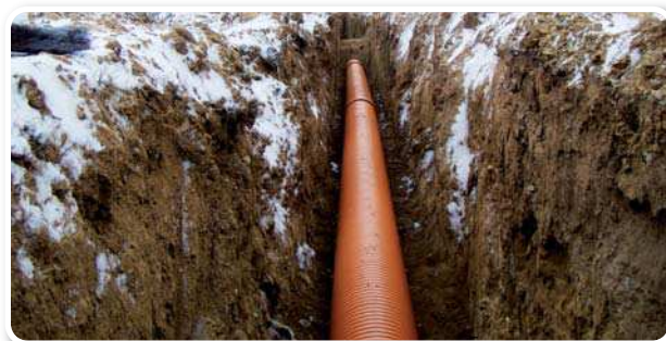
VISTA DE TUBERÍA adequa SANECOR® INSTALADA EN LA ZANJA.
