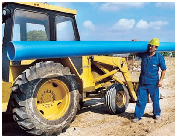
Ejemplo de manipulación-montaje tuberías URATOP
