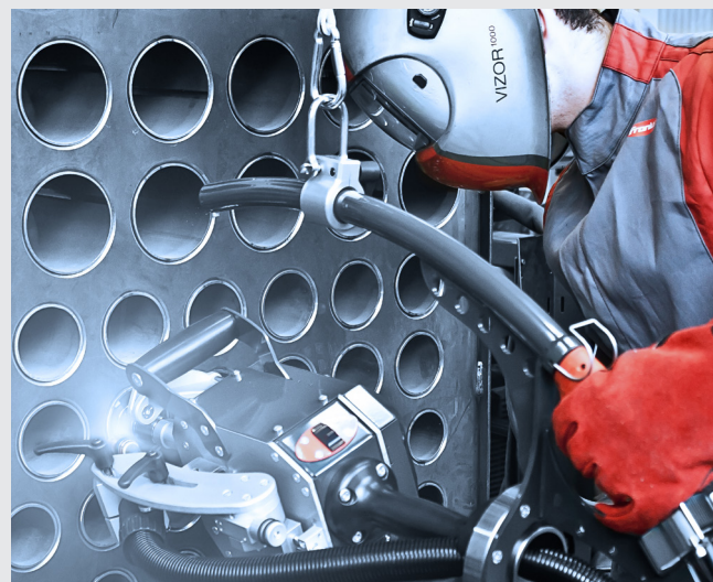
/ Posicionamiento de soldadura horizontal
