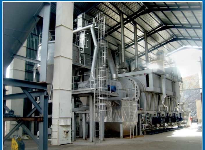
Instalación de Horno en Argelia / Kiln plant in Algeria.
