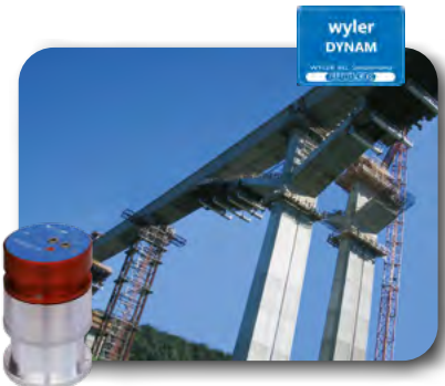
MONITORING OF BRIDGES ÜBERWACHUNG VON BRÜCKEN
