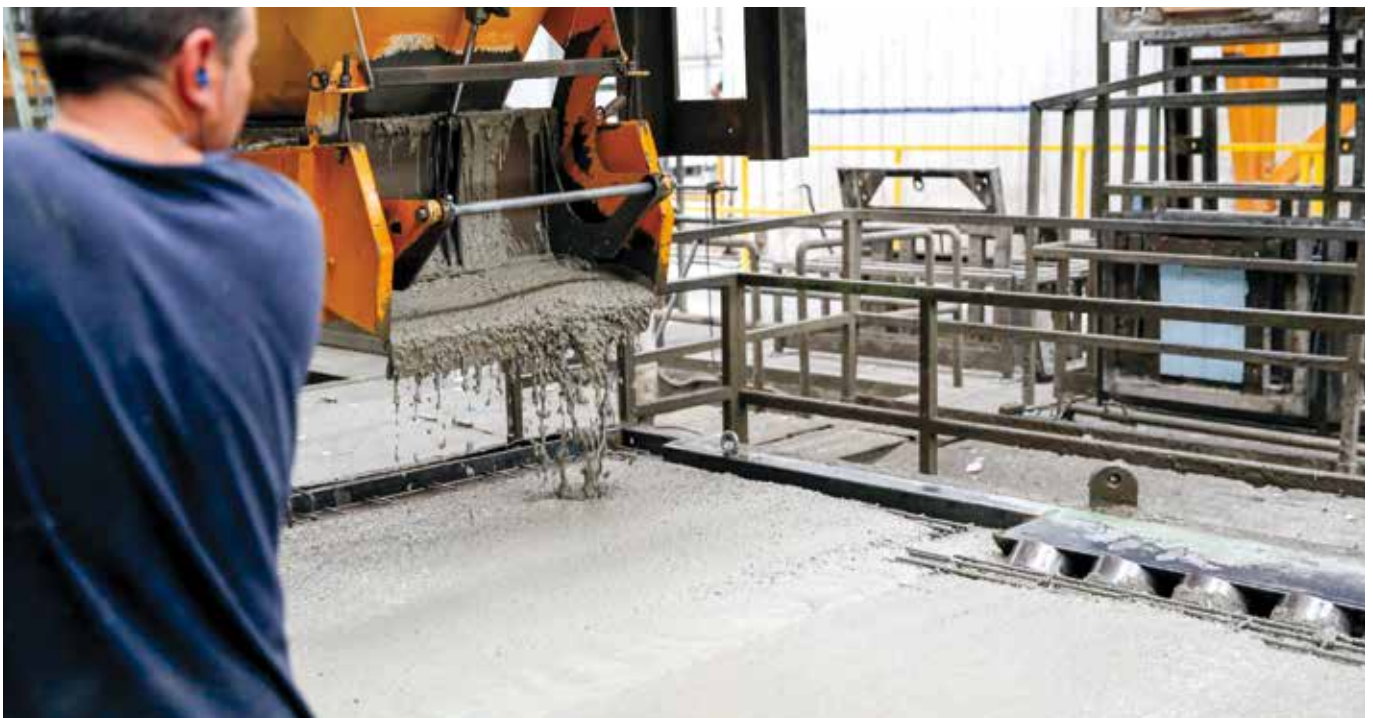
MasterFiber 249 Hormigón prefabricado. Uniblock, Toledo
