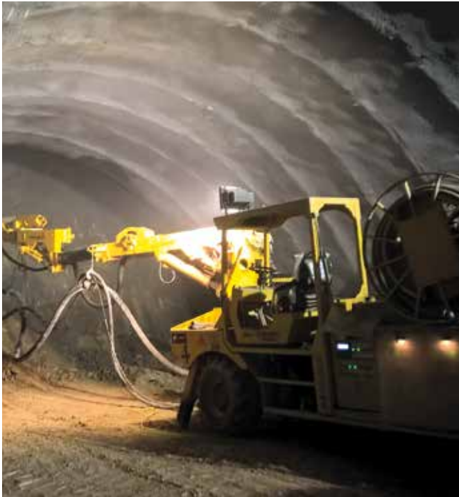
MasterFiber 248 Autovía B-40, Barcelona
