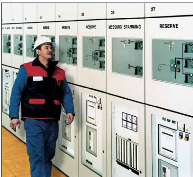
Vista frontal de una apartamenta de barra doble WSB con operador
