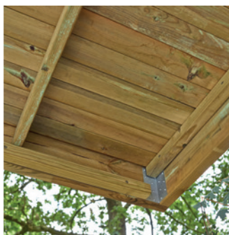
UNIÓN METÁLICA DE LOS LARGUEROS
